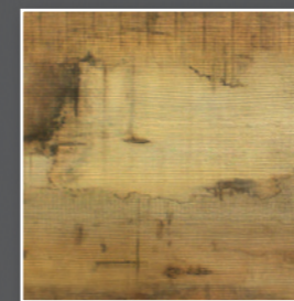
LEGNO MARCIO ROTTEN WOOD
